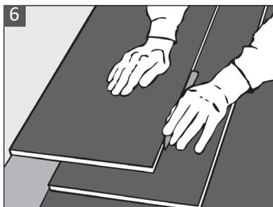
**6** Einpassen der letzten Dielenreihe: Legen Sie exakt auf die zuletzt verlegte Dielenreihe die nachzusägende Diele. Dann zeichnen Sie mit Hilfe einer weiteren Diele den Längsschnitt an. Durch diese Art des Anzeichnens bleibt genügend Abstand zur Wand um die letzte Reihe mittels Zugeisen einzuwinkeln.
